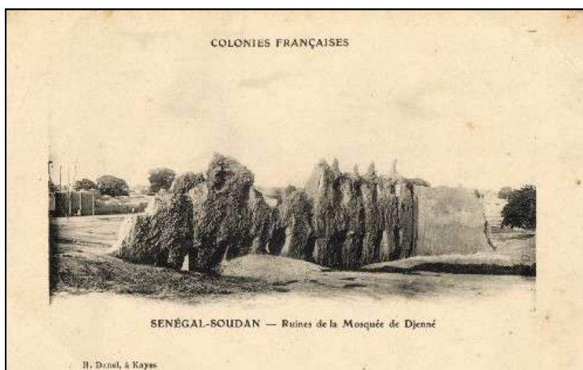
Ruines de la Mosquée de Djenné.
