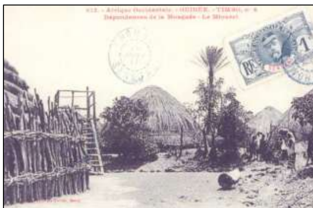
Fig. 8 : Le minaret de la mosquée de Timbo ; carte postale Collection générale Fortier, n°613 (Cliché Georges Meurillon)
