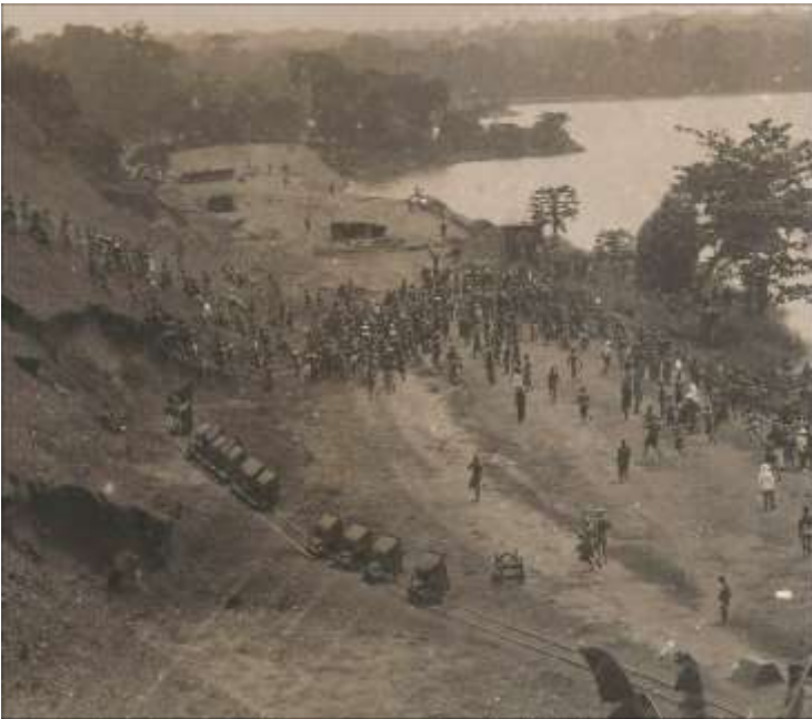
La voie et les wagonnets Decauville, très nettement visibles en bas.
