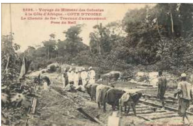
Le Chemin de fer - Travaux d'avancement - Pose du rail Carte postale n°2596, Collection Générale Fortier, Dakar
