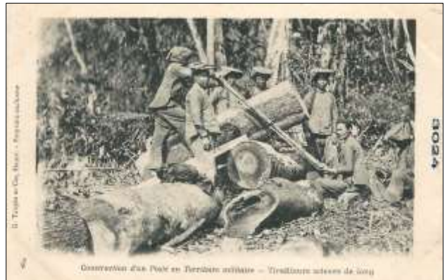
3024 Construction d'un Poste en Territoire militaire – Tirailleurs scieurs de long
