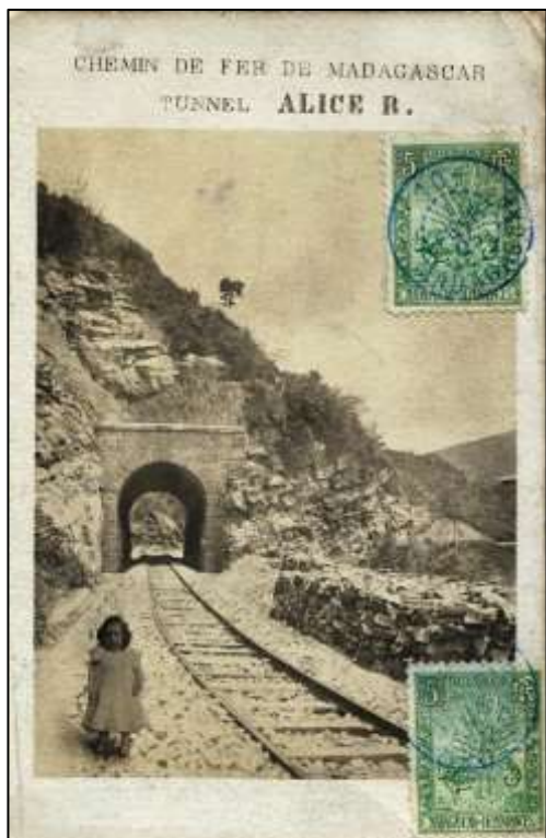
13. Le tunnel Alice, au km 84,5, a été percé en 1904 dans un mince contrefort de roc compact.
