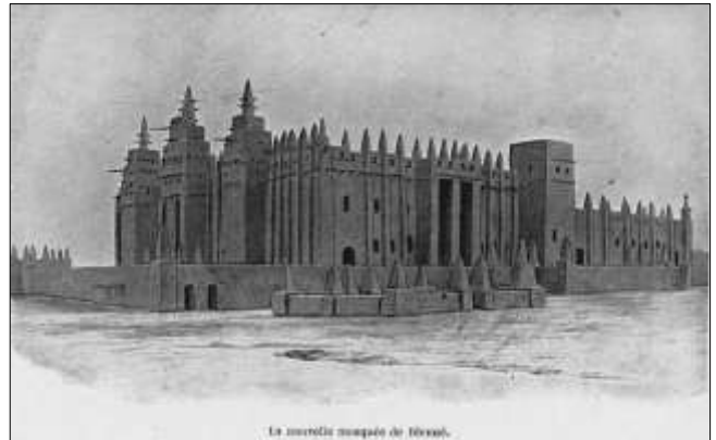
La nouvelle mosquée de Djenné construite à partir de 1906/1907
