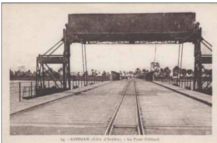
24 - ABIDJAN (Côté d'Ivoire) - Le Pont flottant
