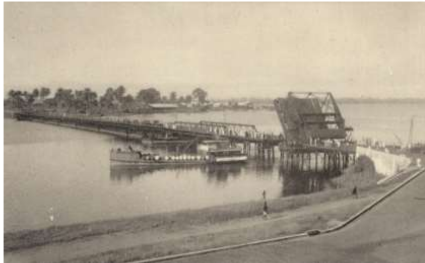
Le pont flottant avec la travée mobile relevée pour laisser passer un chaland automoteur (Édition Hélió Audry, archives J.J. Fadeuilhe)
