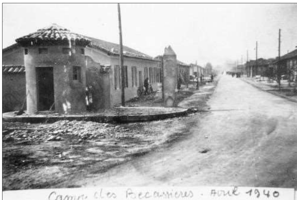
Fig. 1 - Le camp des Bécassières à Sorgues (Vaucluse) : des allures de cité ouvrière Photographie : © Raymond Chabert, Collection des Etudes Sorguaises.
