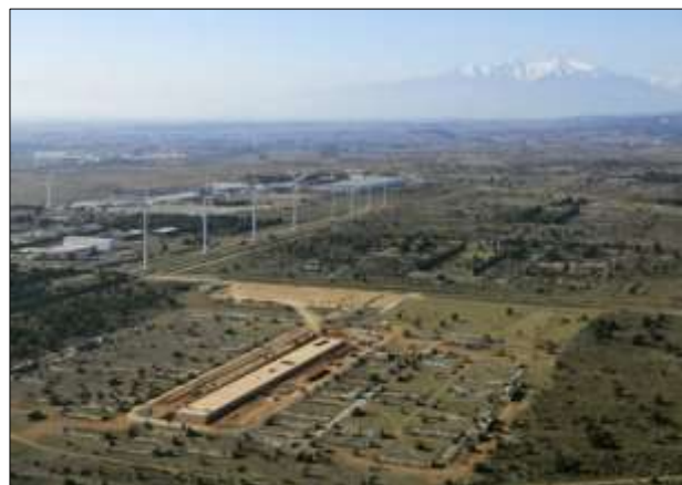
Le chantier, février 2015
