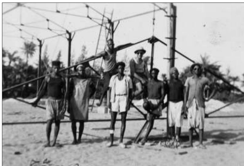
Le montage des bâtiments de l'Institut Pasteur à Sangalkam Collection Paul Genson.
