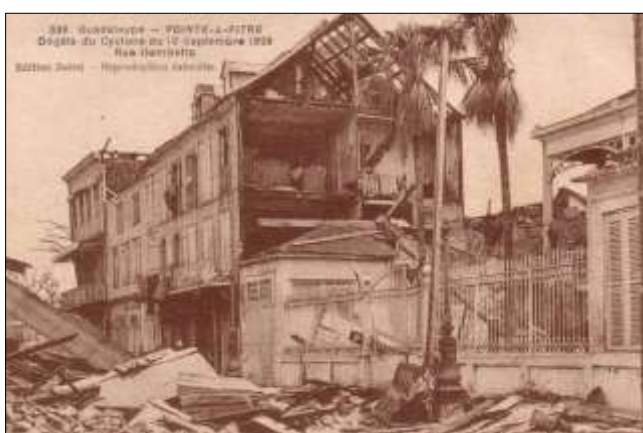
Dégâts du Cyclone... Rue Gambetta
