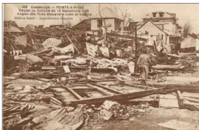
Dégâts du Cyclone... Angles des rue Alexandre Isaac et Vatable
