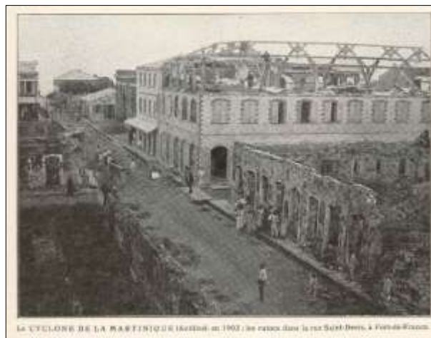
Le cyclone de 1903 à la Martinique : Les ruines dans la rue Saint-Denis à Fort-de-France.
