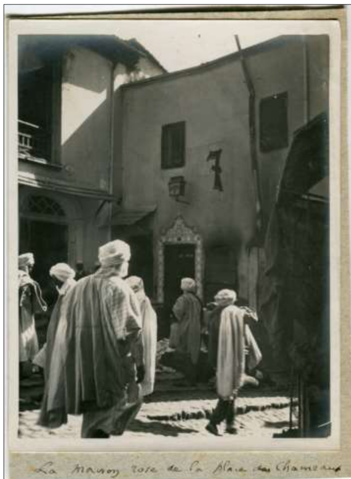
Photo de touriste, vers 1925 8 , après transformation de la façade 9 , annotée « La maison rose de la place des Chameaux ». Collection de l'auteur.
