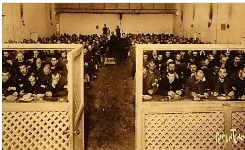
La salle commune du bagnon à Saint-Martin
