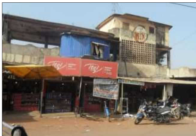
Façade et toit du Vox (Goerg, 2020)
