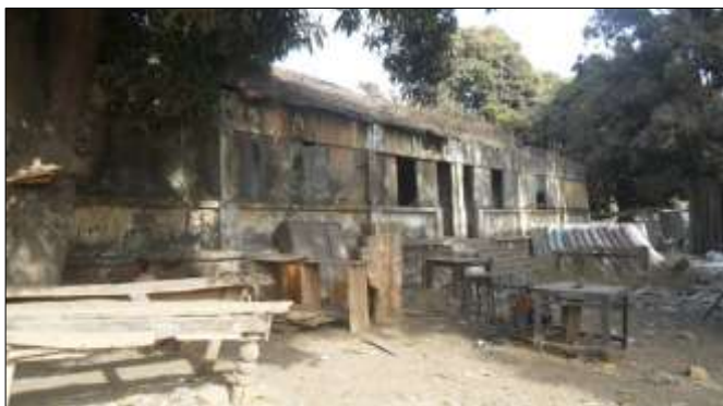
Bâtiment annexe de la gare (ruine)
