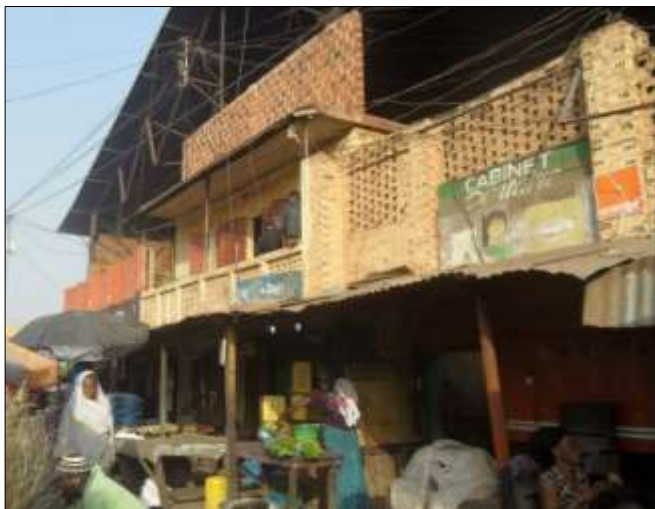
Façade du Rex (Goerg, 2020)
