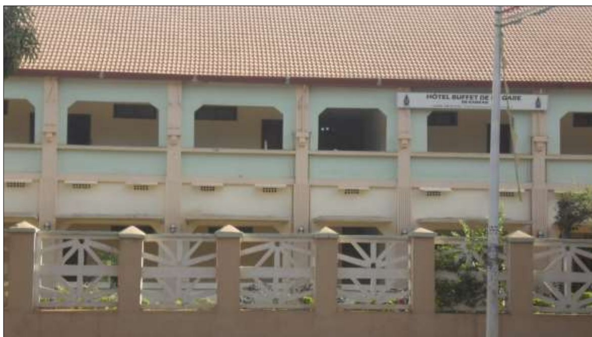
La façade de l'Hôtel Buffet de la Gare aujourd'hui (Goerg, 2020)
