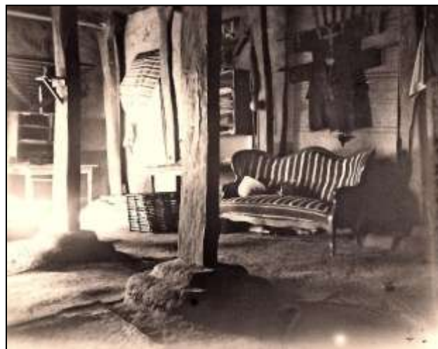
Intérieur de la salle des palabres à Ségou
