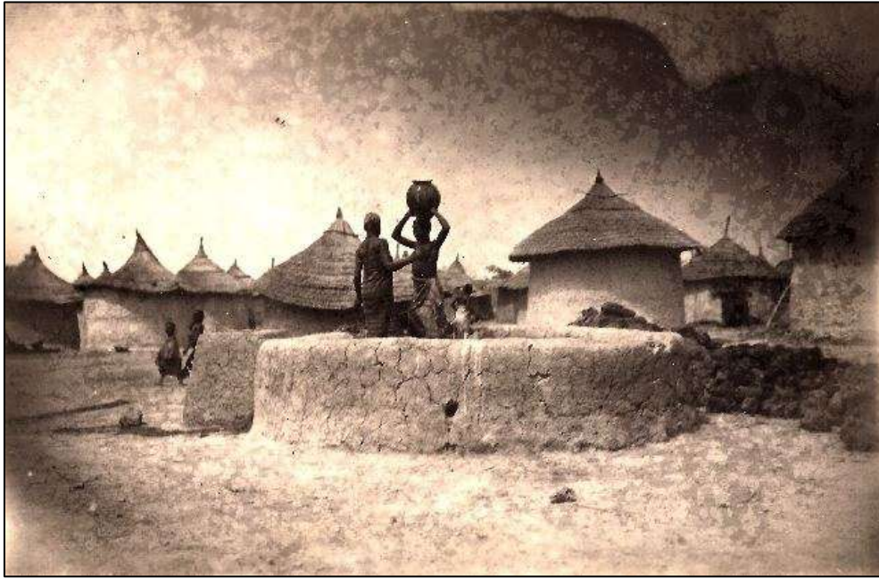
Le puits du poste à Ouagadougou
