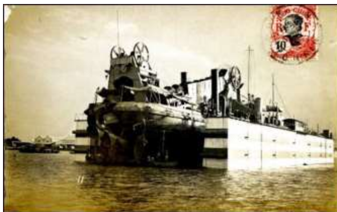
Dragage dans le port d'Hàiphong
