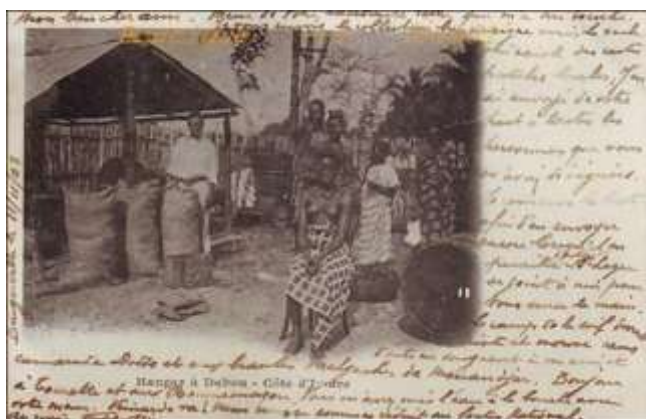
(1) Hangar à Dabou – Côte d'Ivoire
