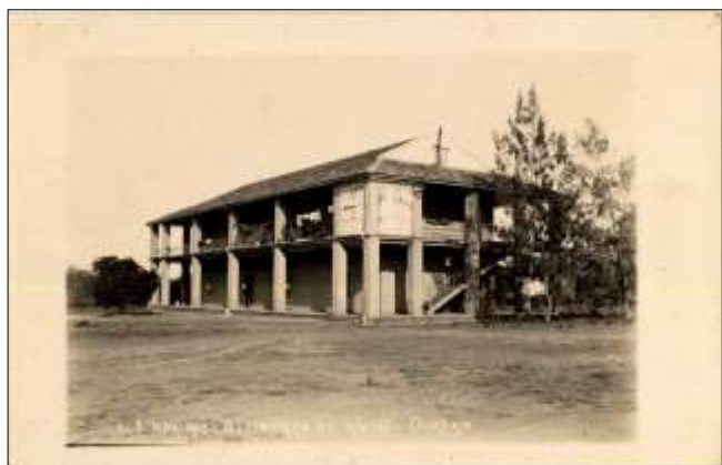
L5. - SPA-AOF - Bâtiments de S/offi[ciers]. Ouakam
